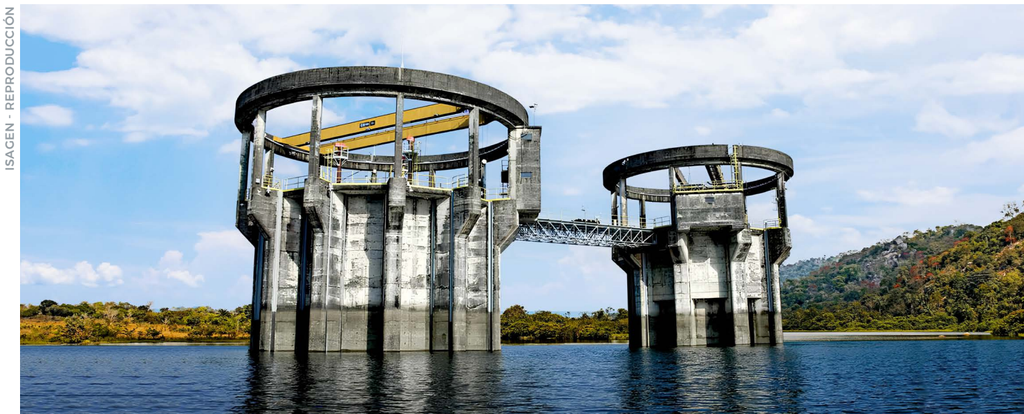
Central hidroeléctrica San Carlos.
